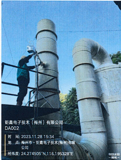
电镀废气排放口 DA002
