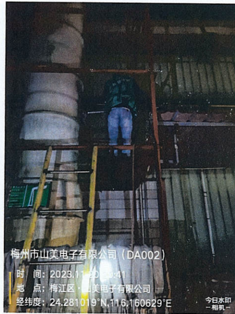
电镀、蚀刻废气排放口 DA002
