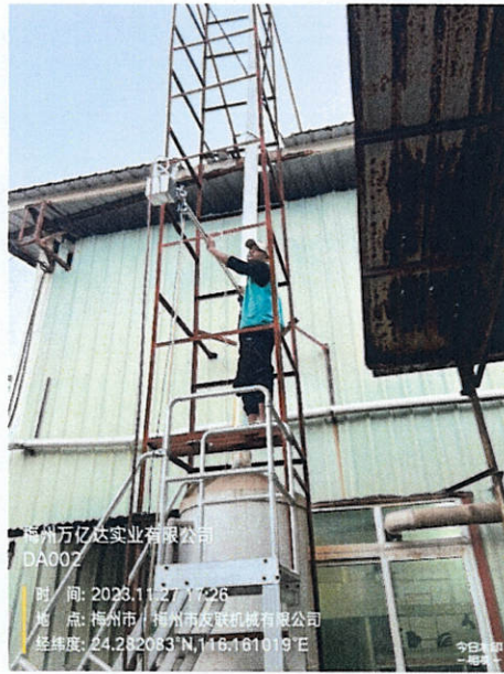
蚀刻废气排放口 DA002
