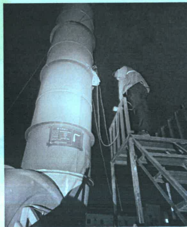
废气处理后采样口 DA010
