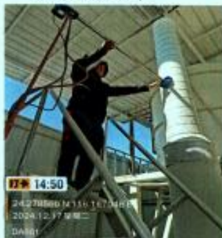
DA001 废气处理后采样口
