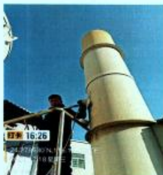
DA008 废气处理后采样口
