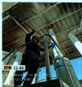
DA002 废气处理后采样口
