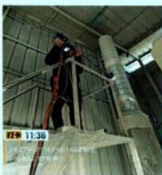
DA012 废气处理后采样口
