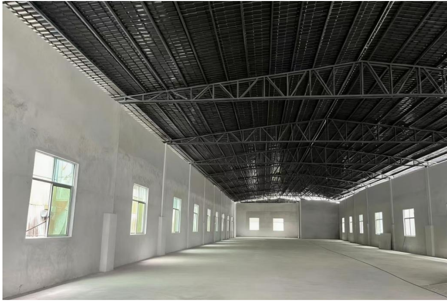
扩建项目厂房现状
