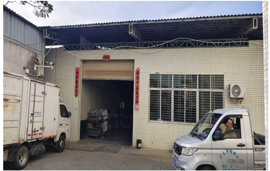
扩建项目东侧科鼎公司电镀车间
