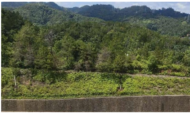
线路沿线现状（湿地松林）
