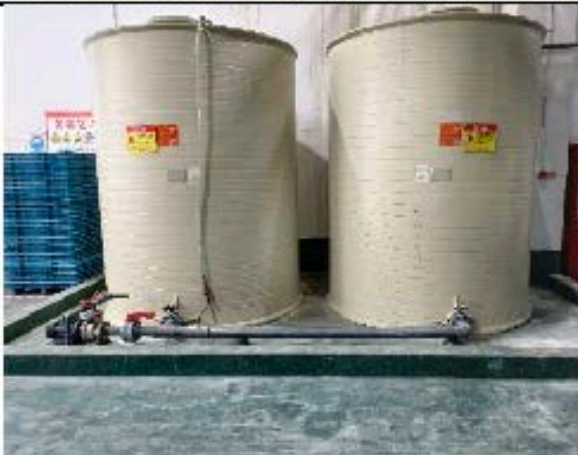
含铬浓液围堰和防泄漏沟渠
