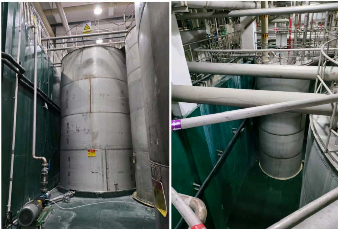
图 7.2-1 低位槽罐区围堰情况
