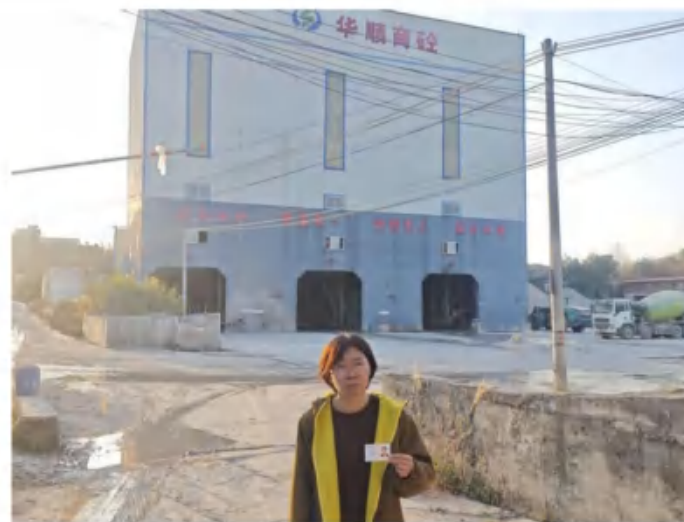
项目北面（华顺混凝土有限公司）
