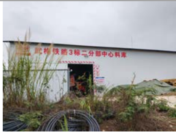
武梅铁路3标二分部中心料库
