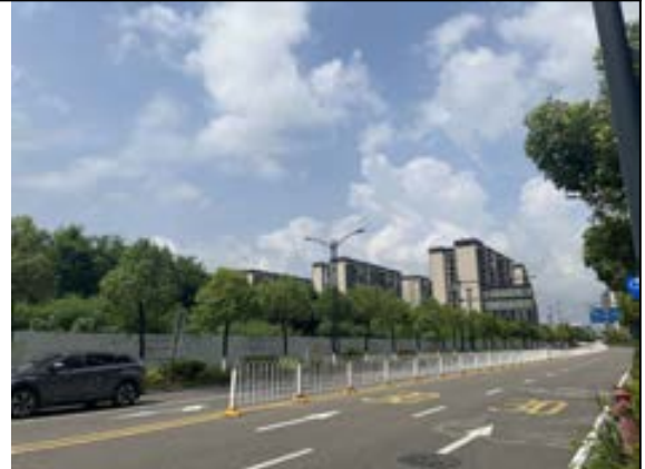
新建约亭变电站北侧现状
