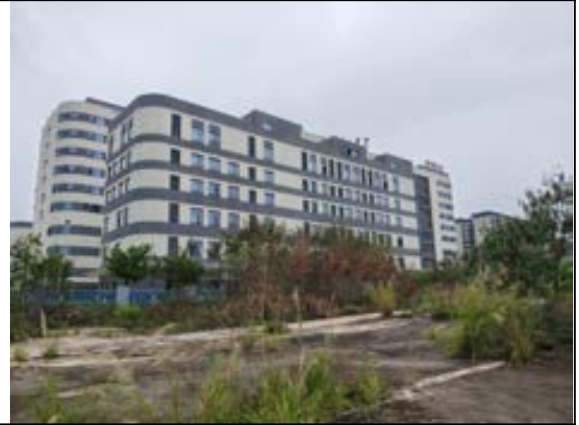
新建约亭变电站南侧现状
